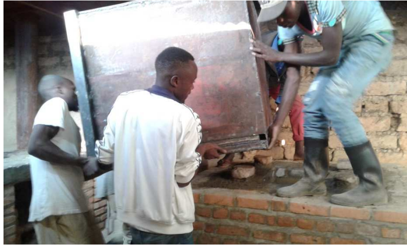
Abb. 2 Die Metallbox wird auf den halbfertigen Ofen gesetzt
