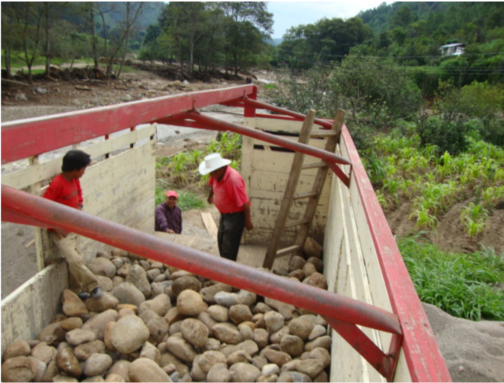
Anlieferung von Baumaterial
