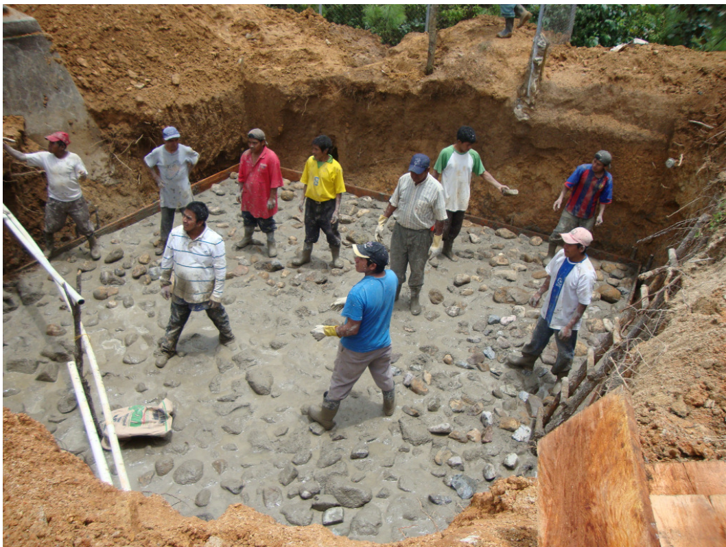
Betonieren des Fundaments
