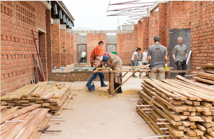
In der Bauphase konnten wir in Zusammenarbeit mit tansanischen Arbeitern die noch fehlenden Teile der Dachkonstruktion der Multi-Purpose-Hall fertigstellen und das Dach eindecken. Zudem haben wir Fenster und Türen sowie Lüftungsgitter eingebaut. Die Küche hat Waschbecken mit fließendem Wasser von einem neu errichteten Hochtank erhalten. Im Innenhof haben wir Leitungen zur Entwässerung eingebaut und diesen gestaltet sowie bepflanzt.
